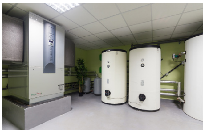
Rekonstrukce bytového domu, vnitřní systém vzduch/voda
