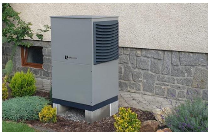
Rekonstrukce rodinného domu, jižní Čechy
