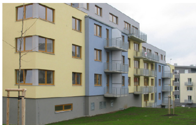
Komplex bytových domů, Praha, vnitřní systém vzduch/voda
